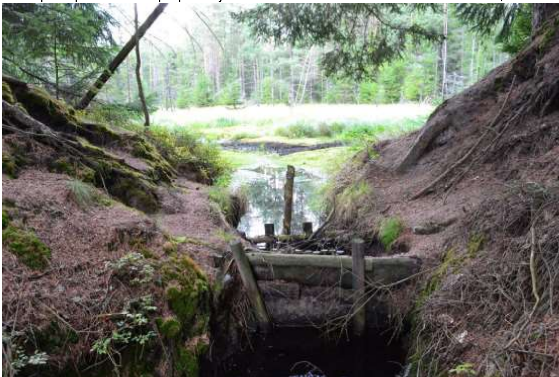
Místo prokopnuté hráze s propouštějící stabilizační hrázkou. Foto: Vladimír Melichar, 4. 9. 2018.
