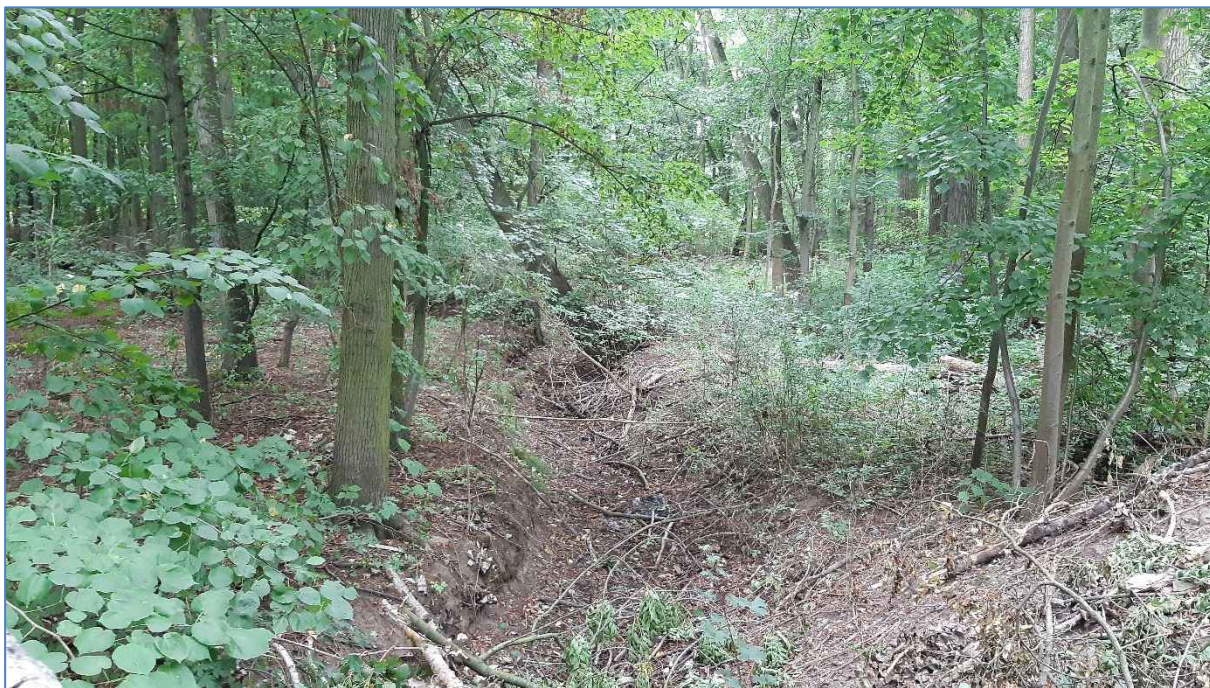
Foto 2. Stav svodnice v úseku těsně před propustkem v létě, kdy je v těchto místech hladina spodní vody níže, než je dno svodnice. V tomto období lužní část rezervace postrádá povrchový odtok. (27. 8. 2020)
