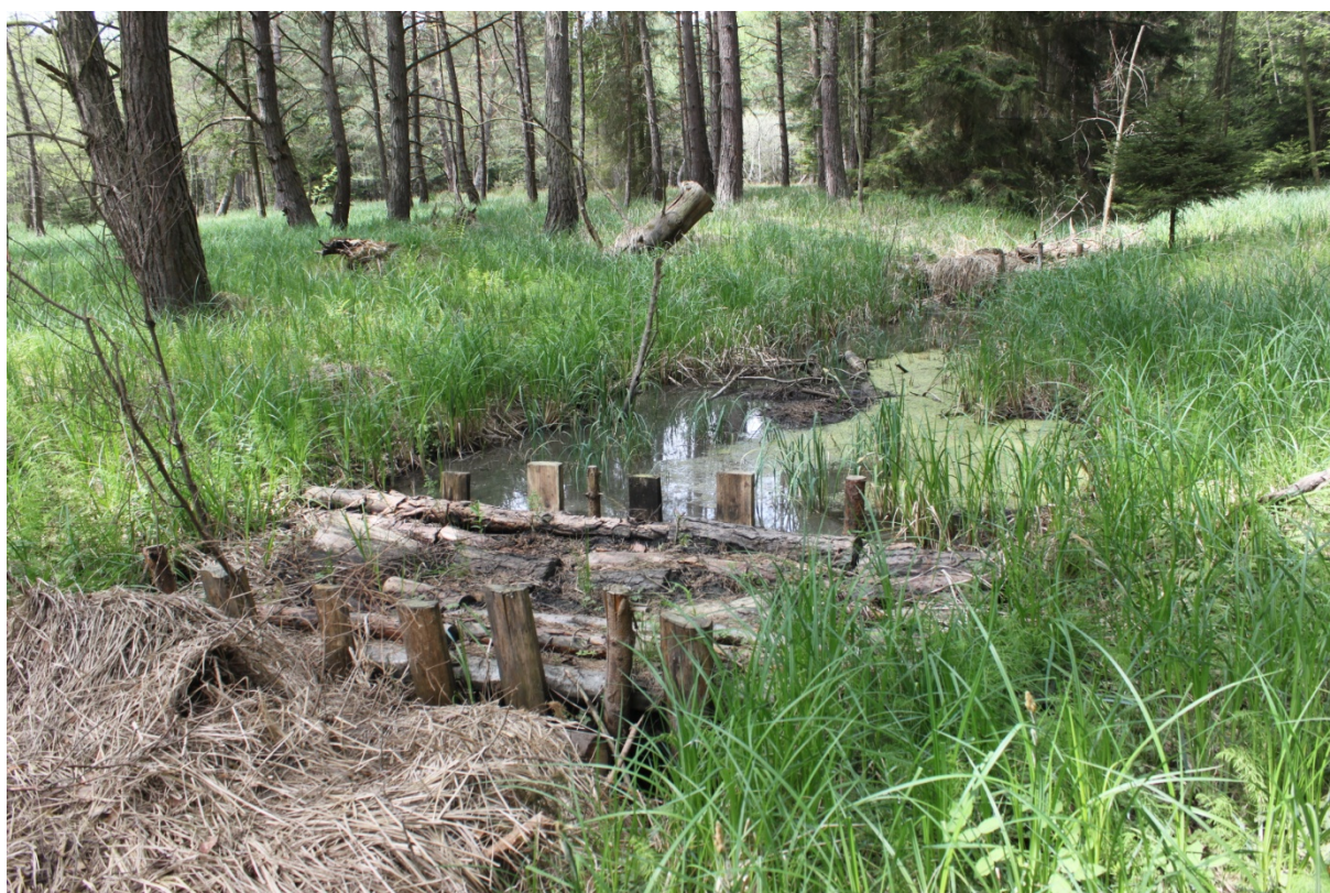
Obr. 4: Přehrážky, budované z místního materiálu, se snaží napravit v minulosti narušený vodní režim, slouží ke zpomalení odtoku vody z lokality a zdvižení hladiny podzemní vody.
