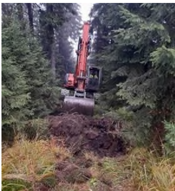
Rekultivace staré traktorové svážnice na prudkém svahu jako opatření k zastavení vodní eroze půdy a k zadržování vody v krajině ve střední části rezervace. Foto vlevo Andrea Milatová, vpravo T. Myslikovjan, 2021.
